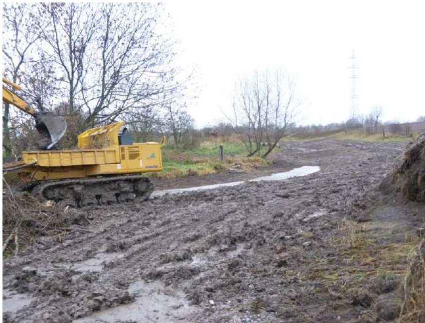
Fin des travaux de terrassement : novembre 2011
