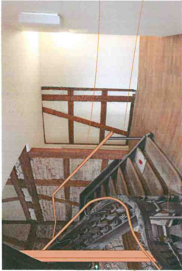
3 - reprise structurelle par un pilier central
